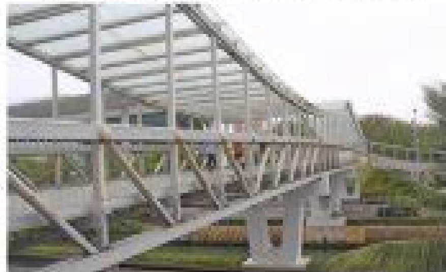
(d) Aluminum tube truss pedestrian bridge (2021)
